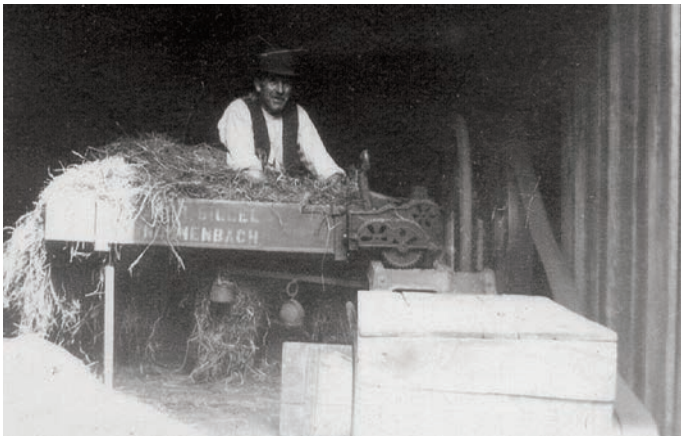
Im Tor des Heustocks auf dem Hof Milz bedient Anton Höfle um 1940 die Futterschneidmaschine. Im Vordergrund der Elektromotor, der über den Flachriemen die Maschine antreibt.
